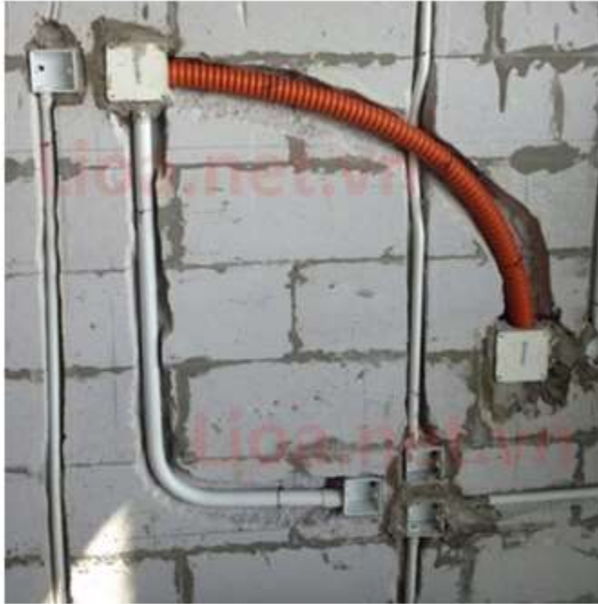
Hình 84. Lắp dây điện ẩn trong tường
