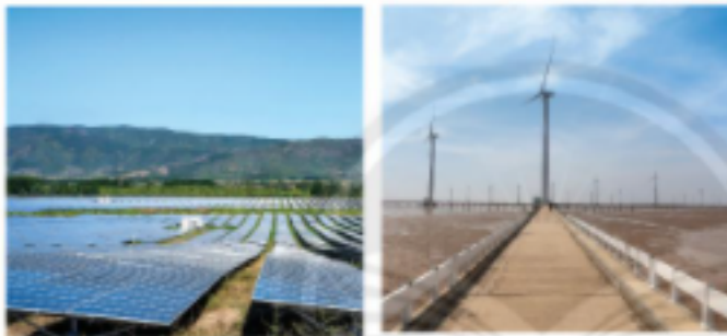
a) Trạm phát điện mặt trời (Khánh Hoà)
