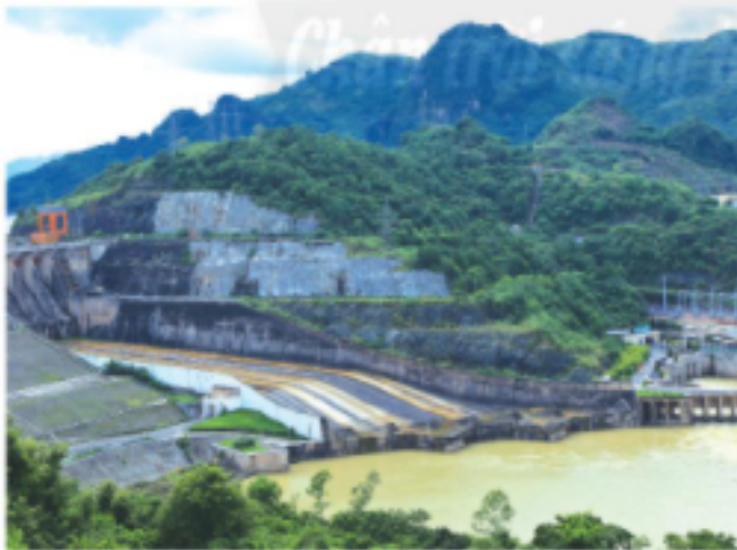
c) Nhà máy thủy điện (Hoà Bình)
