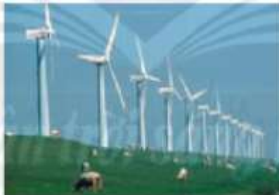
Điện gió Bình Thuận
