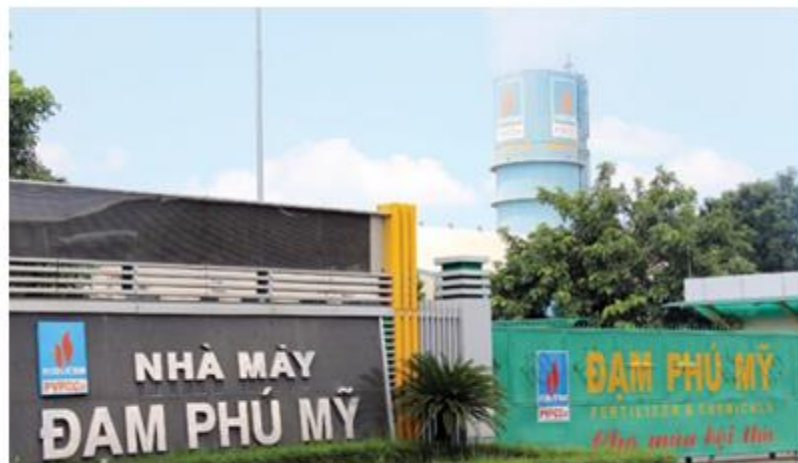
Hình 4: Nhà máy đạm Phú Mỹ.
