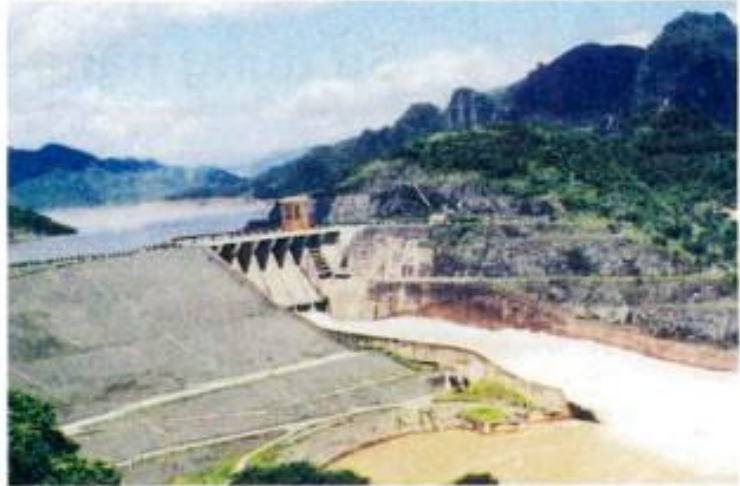
④ Nhà máy thủy điện
